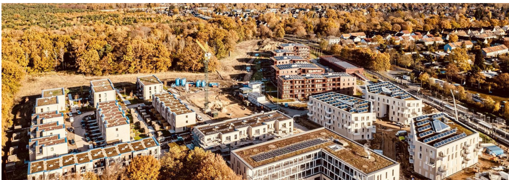
Fallstudie zu einer nachhaltigen Wärme- und Kälteversorgungsanlage, blaues Feld, Bildmitte
